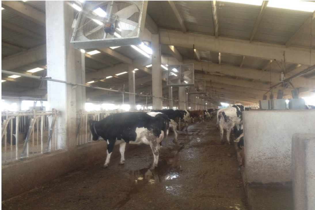
תמונה 2 – מערכת צינון שכוללת מאווררים (DL 1250) ומערכת המטרה, מותקנים לאורך קו ההאבסה, כפי שהופעלו בקיץ 2017.
