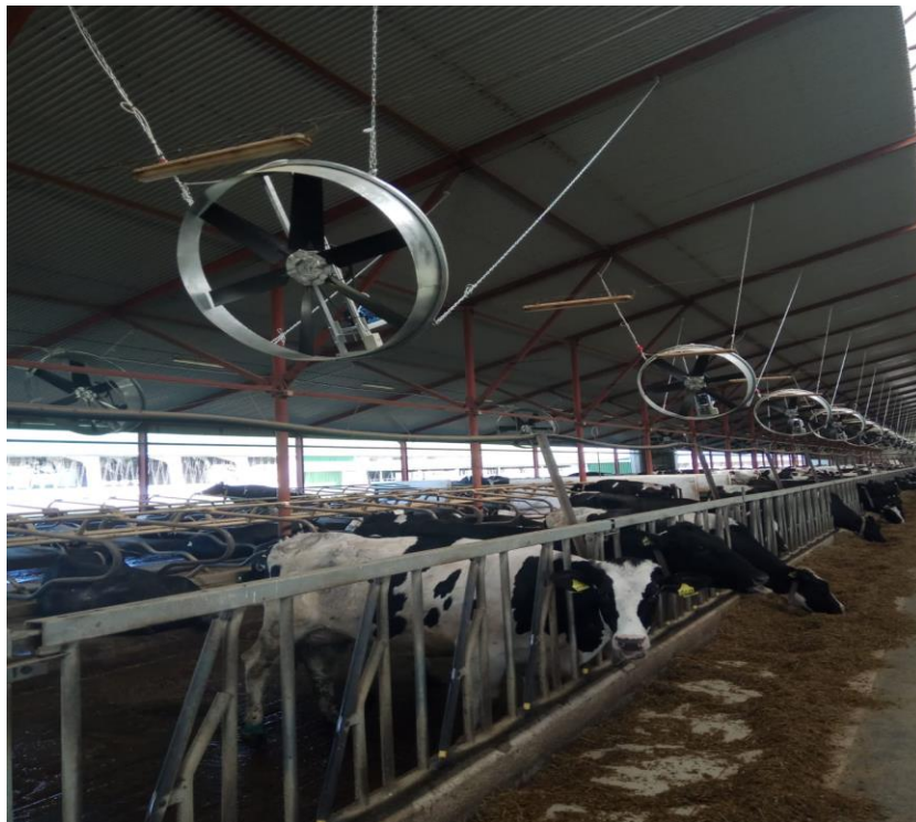
תמונה 3 - מאווררים ומערכת פיזור, המותקנים לאורך קו ההזנה
